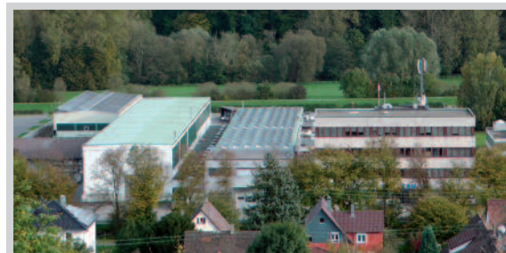
Site de production d'Enzthal
